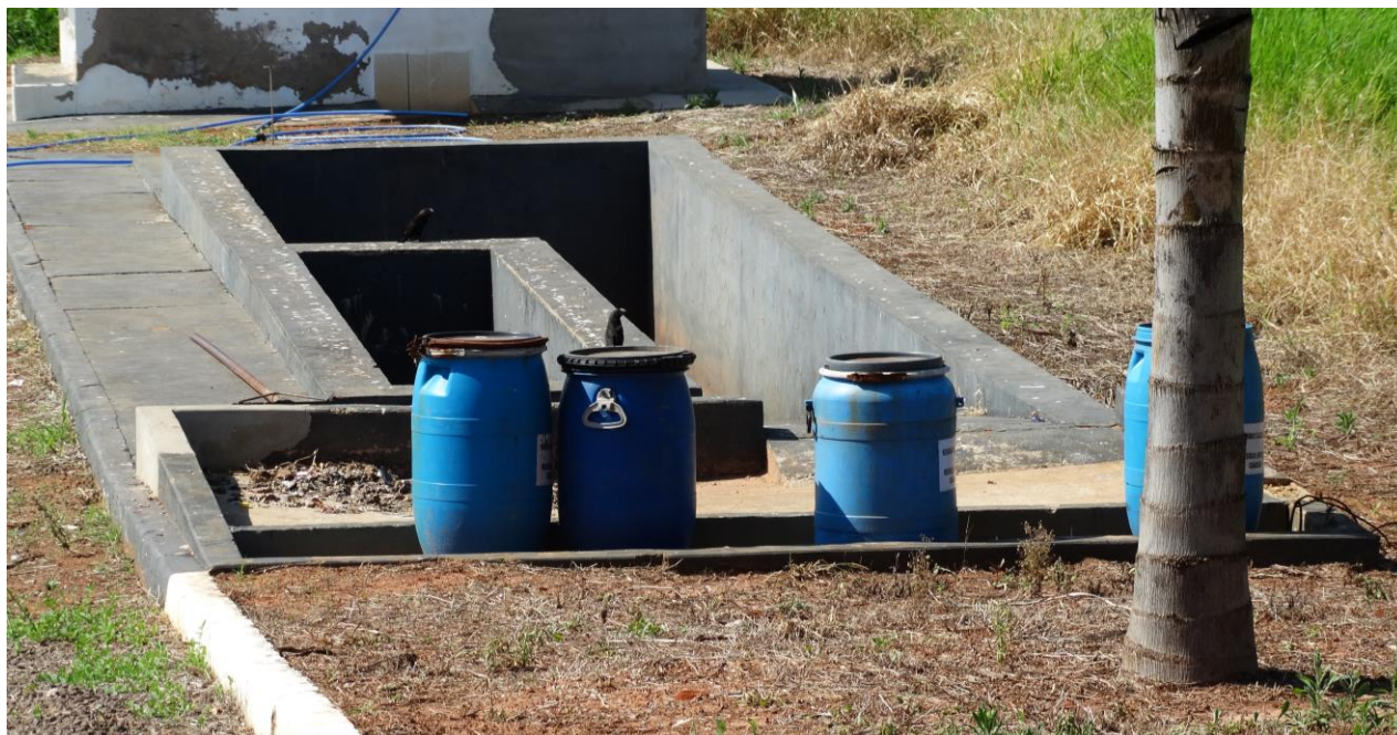
Imagem 48 – lodo originado do esgoto sendo secado e acondicionado em tambores.
